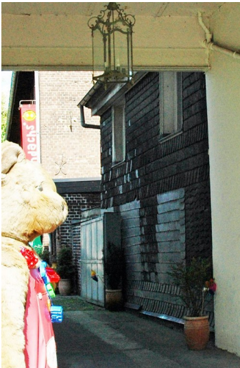
Fachwerkhaus Hauptstraße 86 (Stadt Essen, Baudenkmal Nummer 263) in Essen Kettwig Fotograf/Urheber: Karl-Heinz Buchholz
