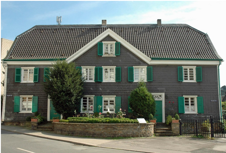
Wohnhaus Engels (Stadt Essen, Baudenkmal Nummer 86), Hauptstraße 63, Essen Kettwig Fotograf/Urheber: Karl-Heinz Buchholz
