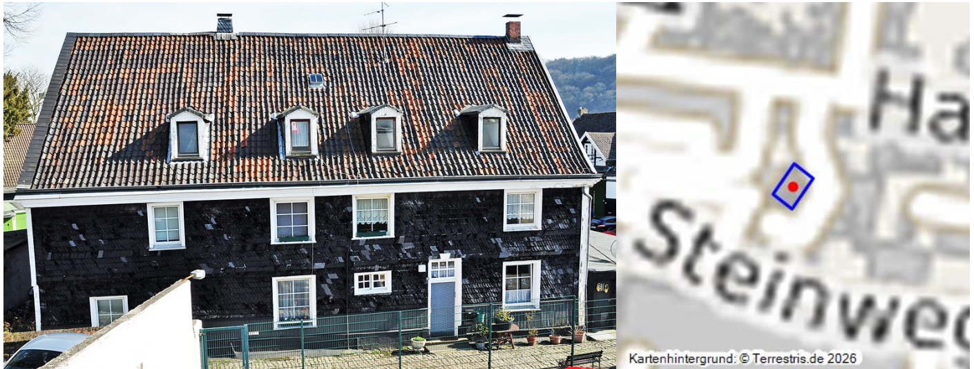
Fachwerkhaus Hauptstraße 37-39 in Essen Kettwig Fotograf/Urheber: Buchholz, Karl-Heinz
