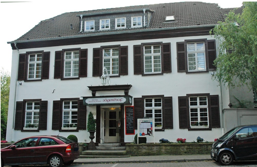
Hotel Jägerhof, Wohnhaus (Stadt Essen Baudenkmal Nummer 258): Hauptstraße 23, Essen Kettwig Fotograf/Urheber: Karl-Heinz Buchholz
