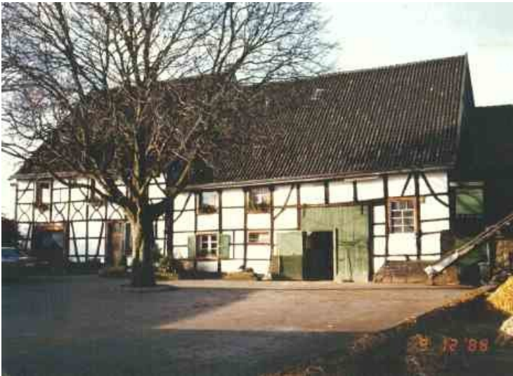
Fachwerkgebäude des Maashofes in Essen-Fischlaken (1988)
