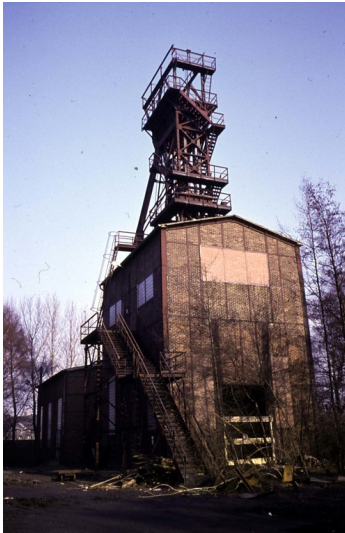
Fördergerüst der Zeche Zollverein 6,9 in Essen Fotograf/Urheber: Buschmann, Walter
