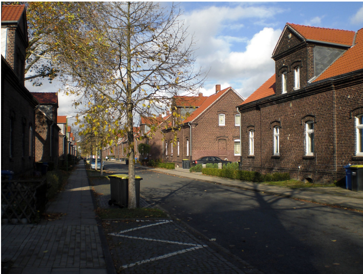
Siedlung Ottekampshof in Essen-Katernberg, Drokamp 4 Fotograf/Urheber: Buschmann, Walter
