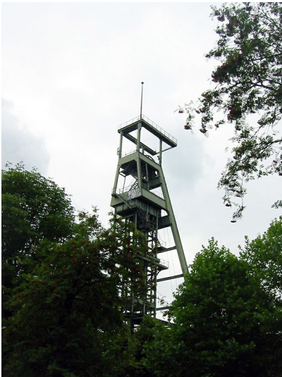
Fördergerüst der Zeche Heinrich (Schacht 3) in Essen-Überraehr-Holthausen (2009) Fotograf/Urheber: Knöchel, Franz-Josef
