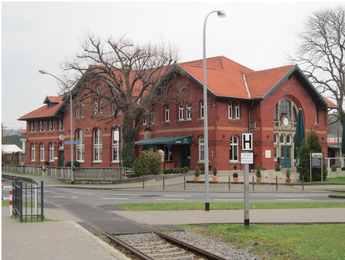
Essen-Kupferdreh, Ansicht des Empfangsgebäude Bahnhof Kupferdreh (2016) Fotograf/Urheber: Claus Weber
