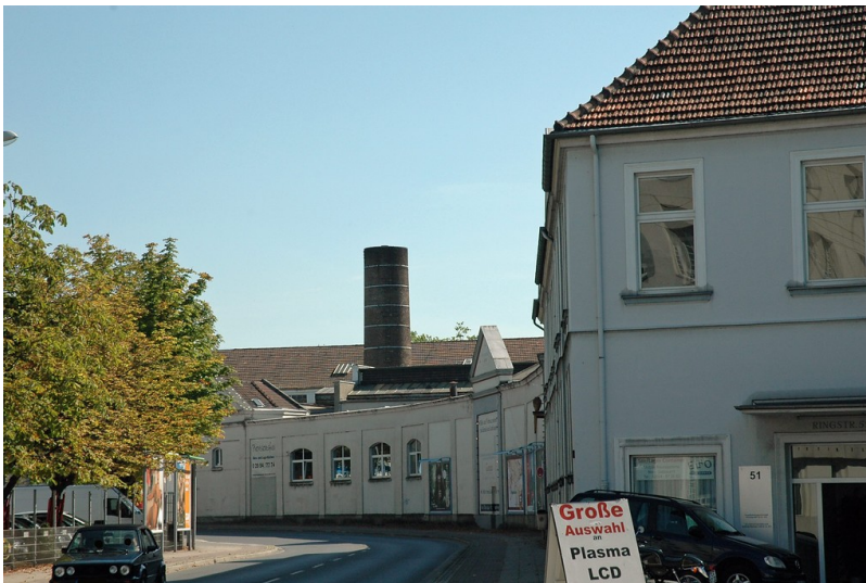
Gewerbegebiet auf dem Gelände der ehemaligen Textilfabrik Scheidt, Essen Kettwig Fotograf/Urheber: Karl-Heinz Buchholz
