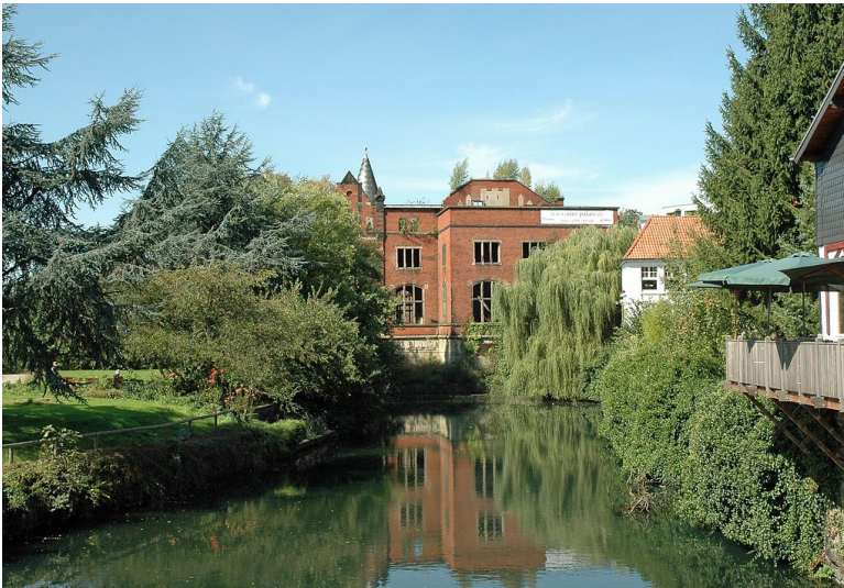
Turbinenhaus der ehemaligen Firma Scheidt, Essen Kettwig Fotograf/Urheber: Karl-Heinz Buchholz
