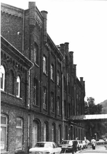
Historisches Foto aus der Eintragung Denkmalpflege Essen Baudenkmal Nummer 859 Textilfabrik Klein-Schlatter Fotograf/Urheber: ohne Angabe
