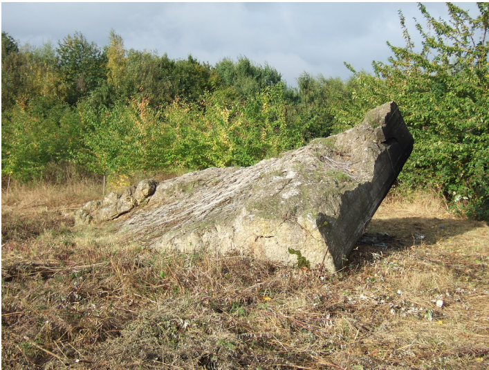
Die Decke des gesprengten Bunkers in Zülpich-Langendorf (2013) Fotograf/Urheber: Hoppe, Wiebke
