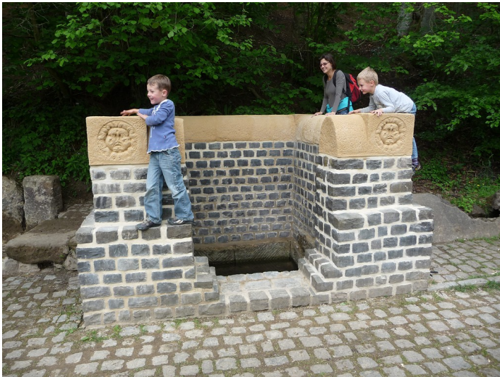
Das Bild zeigt das sanierte Absetzbecken am Grünen Pütz bei Nettersheim (2012). Fotograf/Urheber: Ristow, Imke
