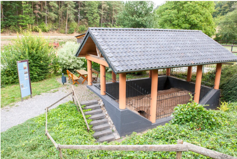
Schutzbau der kleinen Aquäduktbrücke bei Mechernich-Vollem (2023) Fotograf/Urheber: Marcel Zanjani
