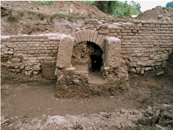
Aquäduktbrücke des Römerkanals bei Mechernich-Vollem (1981) Fotograf/Urheber: Grewe, Klaus
