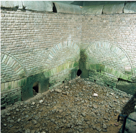
Die Brunnenstube "Klausbrunnen" des Römerkanals bei Mechernich-Kallmuth (2011) Fotograf/Urheber: Grewe, Klaus
