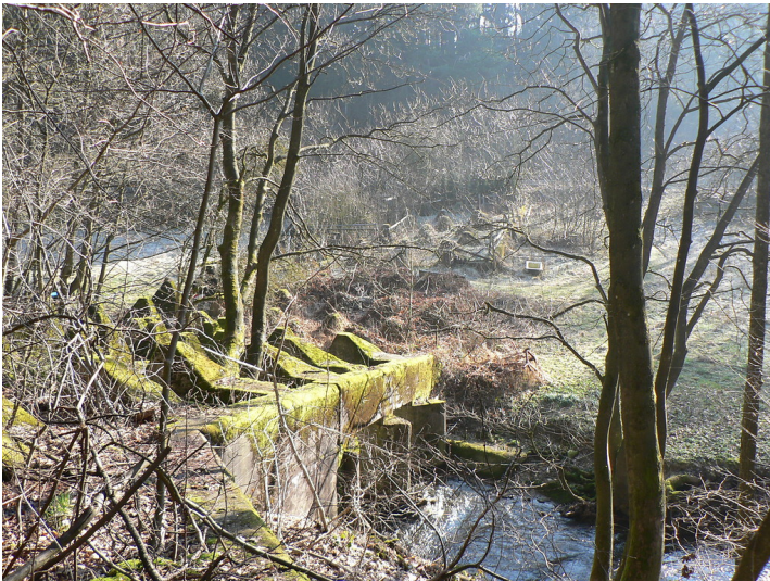
Panzersperre über den Grölisbach bei Roetgen (2009) Fotograf/Urheber: Unbekannt
