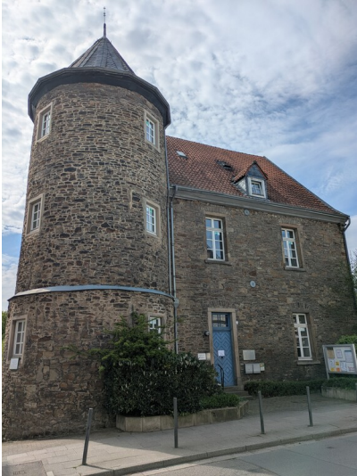
Der ehemalige mittelalterliche Rittersitz Haus Heck in Essen-Werden (2025). Fotograf/Urheber: Samuel Dreßen
