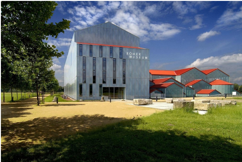
LVR-RömerMuseum im Archäologischen Park Xanten, Außensicht des Museumsbaus mit den Thermen rechts (2011) Fotograf/Urheber: Thünker, Axel (DGPh)
