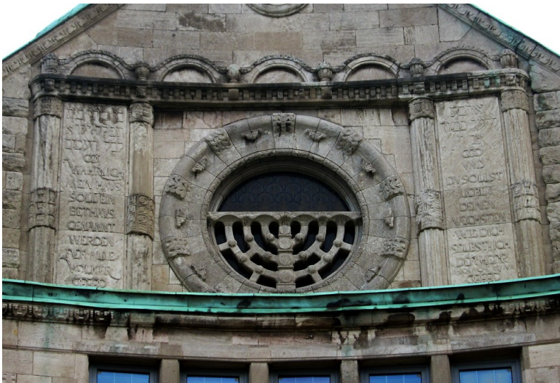
Detailansicht der oberen Westfassade der Alte Synagoge Essen (2014) Fotograf/Urheber: Knöchel, Franz-Josef
