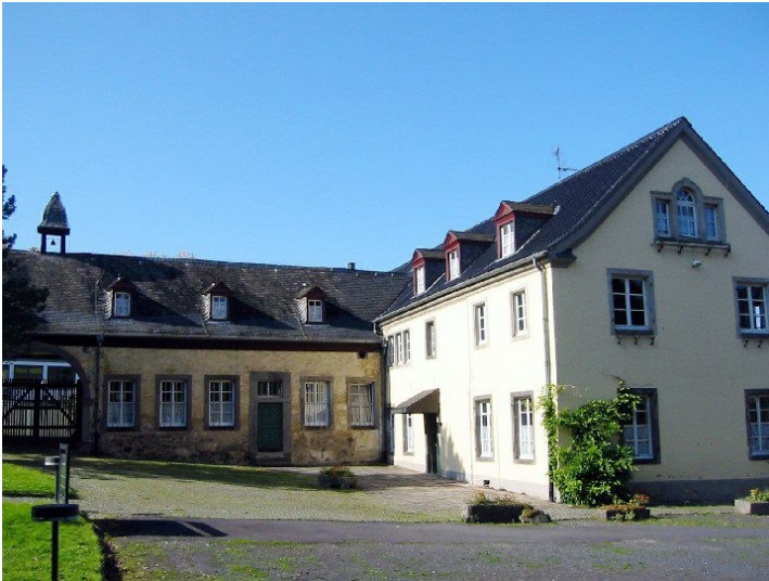
Ehemalige Wirtschaftsgebäude der Abtei Heisterbach (2009).
