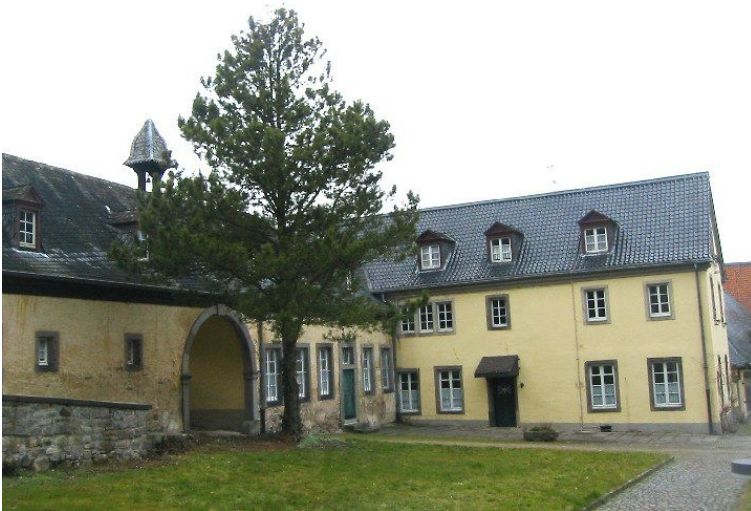
Ehemalige Wirtschaftsgebäude der Abtei Heisterbach (2009). Fotograf/Urheber: Knöchel, Franz-Josef
