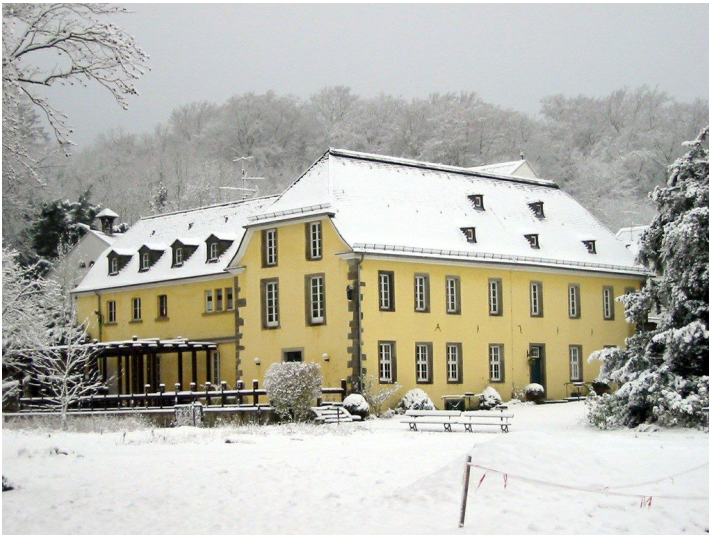
Ehemalige Wirtschaftsgebäude der Abtei Heisterbach im Schnee (2010). Fotograf/Urheber: Knöchel, Franz-Josef
