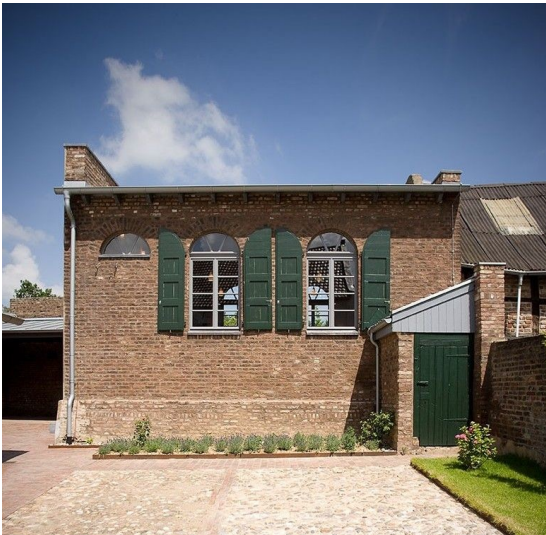
Südfassade der Landsynagoge Rödingen Fotograf/Urheber: Andreas Schiblon
