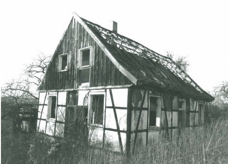
Schäferkotten Rennecke in Essen-Schuir (1985). Fotograf/Urheber: UDB Essen
