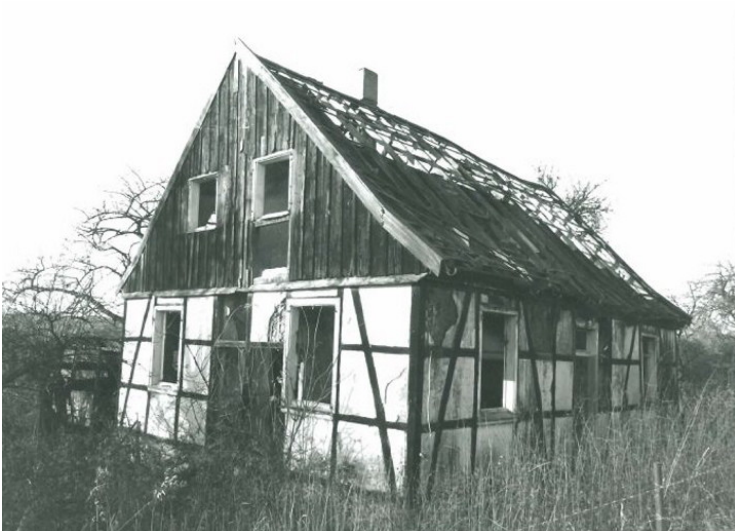
Schäferkotten Rennecke in Essen-Schuir (1985). Fotograf/Urheber: UDB Essen
