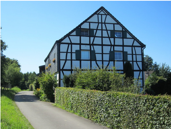
Fachwerkhaus in Essen-Fischlaken, Fischlaker Höfe 37 (2012). Fotograf/Urheber: Es-Punkt-Ge-Punkt
