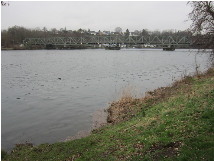
Essen-Kupferdreh, Ruhrtalbahn, Eisenbahnbrücke Heisingen - Kupferdreh (2016) Fotograf/Urheber: Claus Weber
