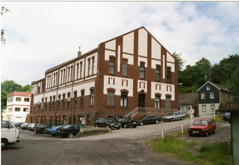
Verwaltungs- und Kauengebäude der Zeche Viktoria in Essen Fotograf/Urheber: Buschmann, Walter
