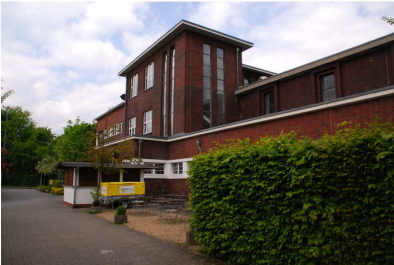
Ehemaliges Verwaltungsgebäude der Zeche Helene im Helenenpark in Stoppenberg Fotograf/Urheber: Nicole Fischer
