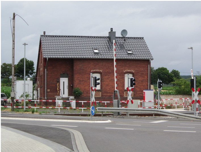
Bahnhof Arloff, Empfangsgebäude der EKB (2015) Fotograf/Urheber: Claus Weber
