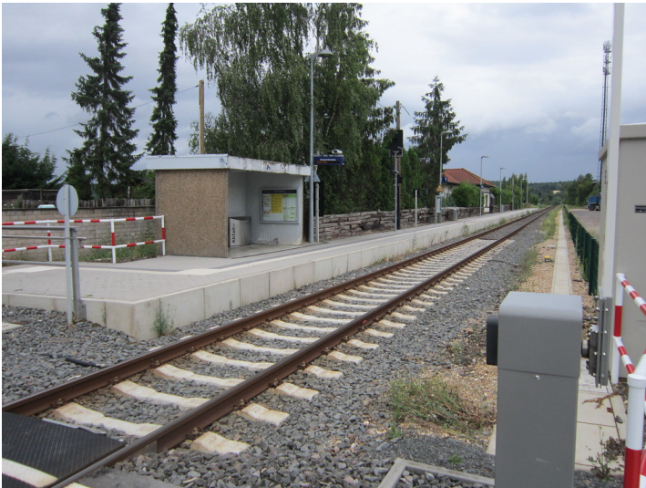
Bahnhof Arloff (2015) Fotograf/Urheber: Claus Weber
