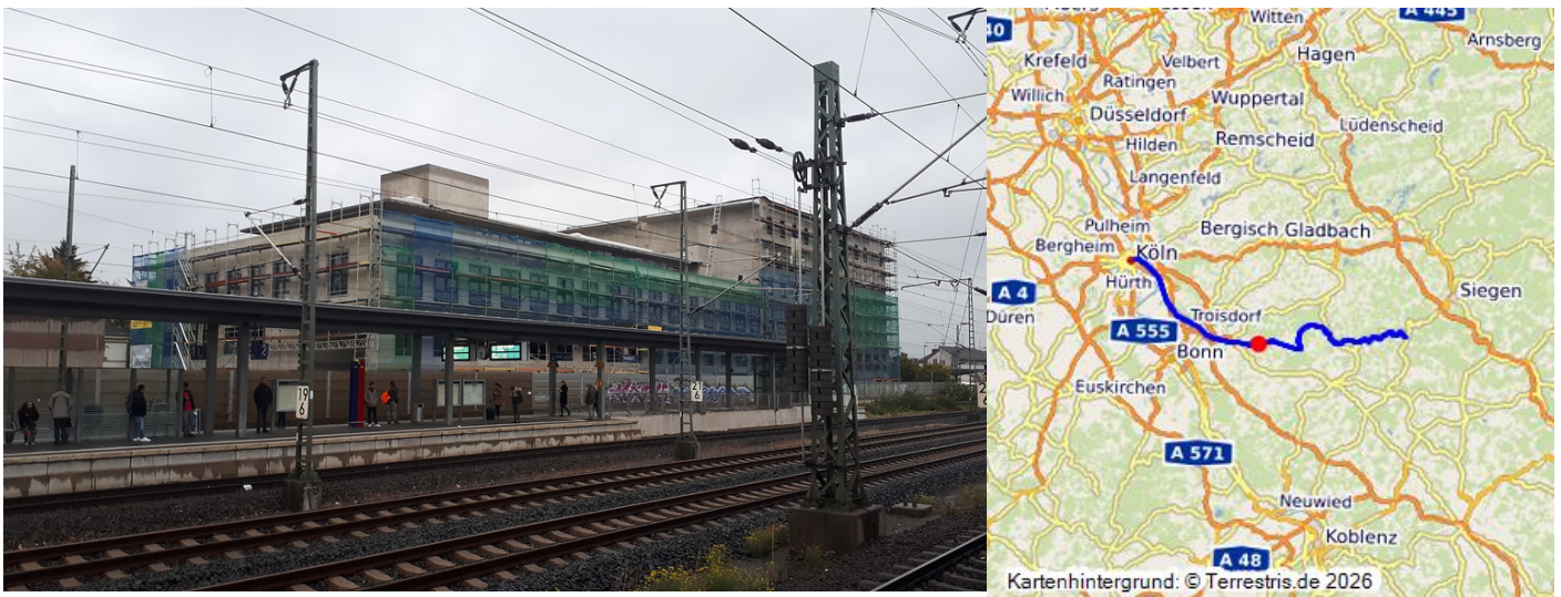
Das noch im Bau befindliche neue Bahnhofsgebäude in Troisdorf, Blick vom Bahnsteig auf den Neubau (2018).
