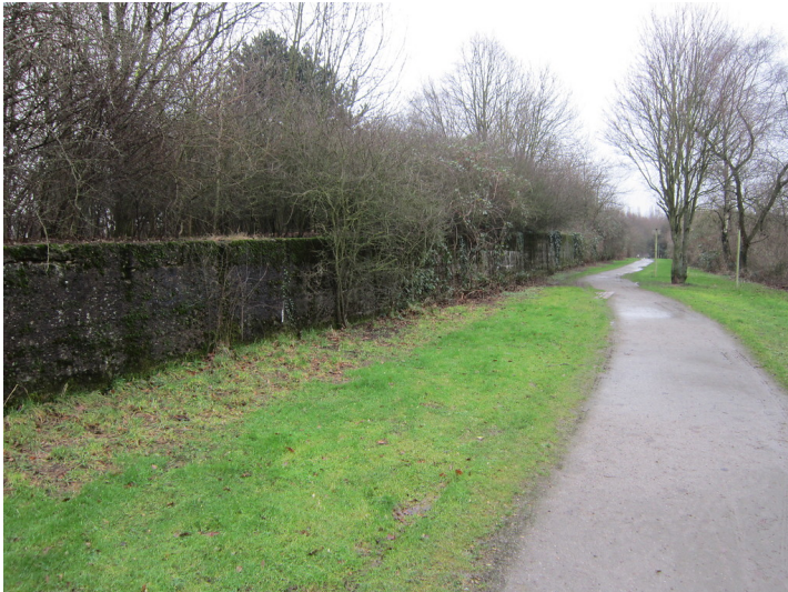
Verschiebebahnhof Bergheim (b. Moers) in Duisburg, Trompeter Straße. Mauer des ehemaligen Ablaufberges (2015) Fotograf/Urheber: Claus Weber
