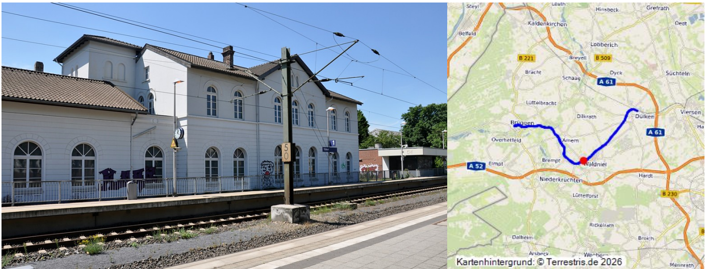
Das Empfangsgebäude Bahnhof Dülken, Blick auf die Gleisseite (2017). Fotograf/Urheber: Franziska Ostfeld
