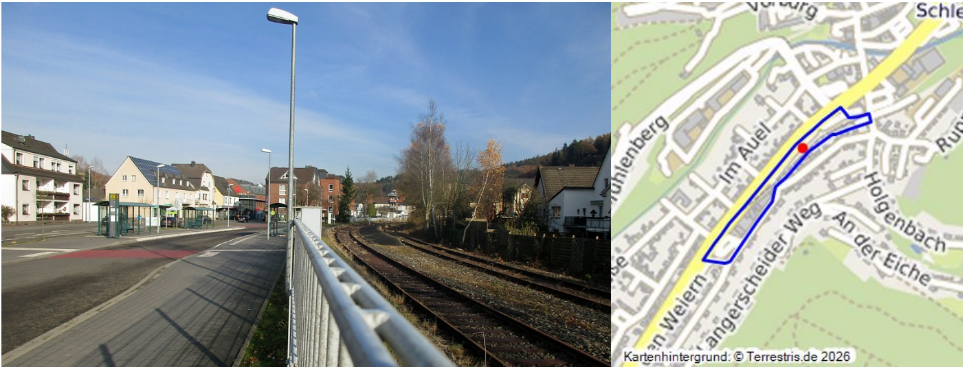
Der Bereich des früheren Bahnhofs Schleiden der Oleftalbahn, heute Busbahnhof (2016).
