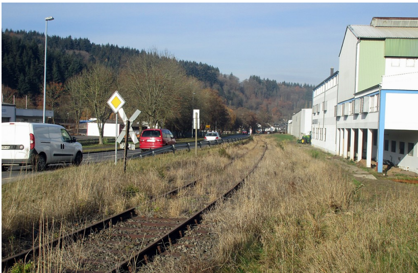
Gleise der Eisenbahnstrecke Kall - Hellenthal (Olefbalbahn) am Ortsausgang von Schleiden, Blumenthaler Straße (2016).
