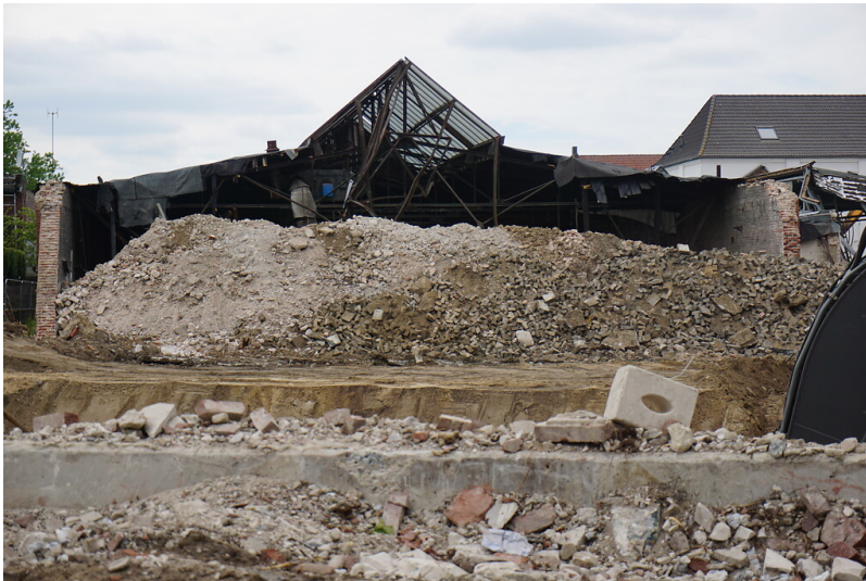
Rees, Betriebshof der Kleinbahn Wesel-Rees (2020). Abriss der ehemaligen Lokhalle Fotograf/Urheber: Claus Weber
