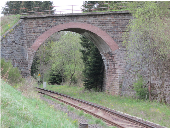
Brücke der Eisenbahnstrecke Ahrdorf-Blankenheim (Wald) (2012) Fotograf/Urheber: Weber, Claus
