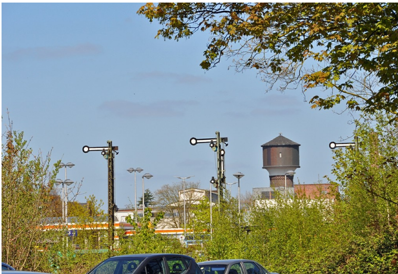
Blick auf Bahnanlagen am Bahnhof in Goch, von der Emmericher Straße. Ausfahrtsignale Richtung Geldern, Wasserturm (2016). Fotograf/Urheber: Felicitas Gildenhard
