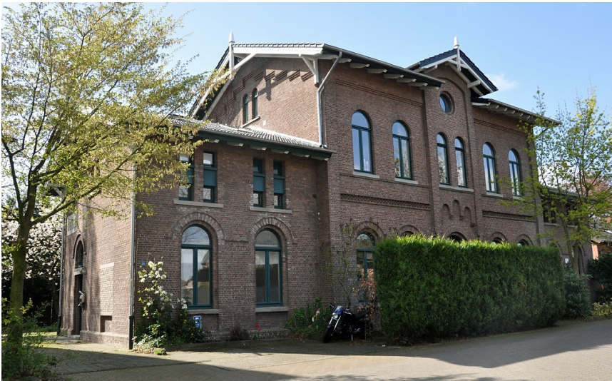
Das Empfangsgebäude des Bahnhofs Geldern (C.M.) der Köln-Mindener Eisenbahn (2016). Fotograf/Urheber: Felicitas Gildenhard
