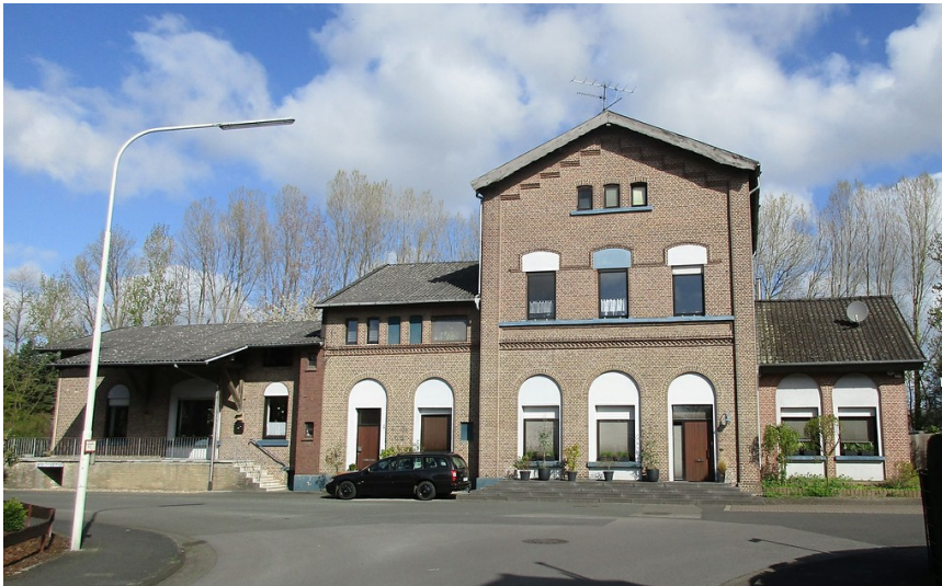
Empfangsgebäude Bahnhof Issum, südliche Ansicht, Straßenseite (2016). Fotograf/Urheber: Felicitas Gildenhard
