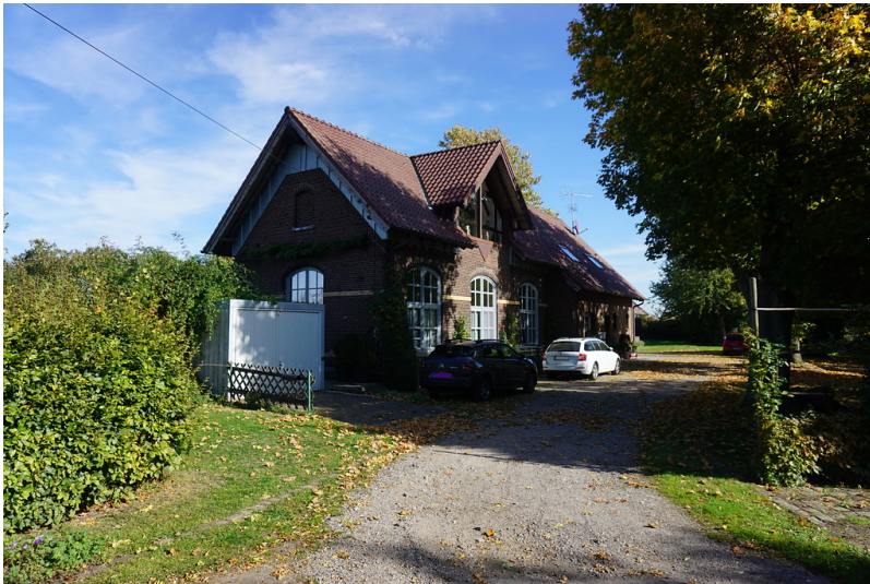
Bahnhof Menzelen-Ginderich der Boxteler Bahn, Empfangsgebäude, Straßenseite (2018) Fotograf/Urheber: Claus Weber
