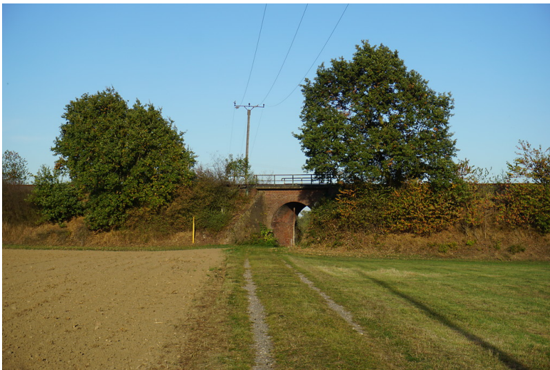
Brücke der Bahnstrecke Rheinhausen - Xanten, beim Bongershof (2018) Fotograf/Urheber: Claus Weber
