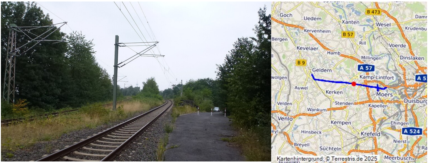
Bahnhof Baerl in Duisburg (2021) Fotograf/Urheber: Wilhelm Damschen
