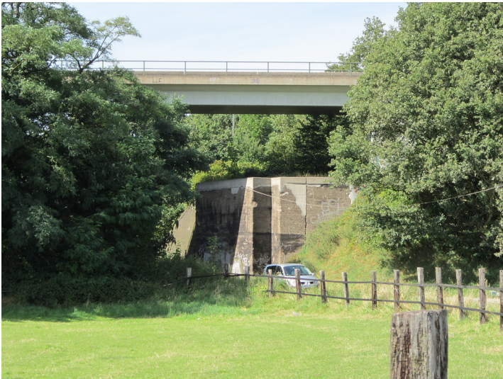
Eisenbahnbrücke bei Gerdt in Duisburg, Bahnstrecke Baerl - Geldern, Blick von Süden (2012) Fotograf/Urheber: Claus Weber
