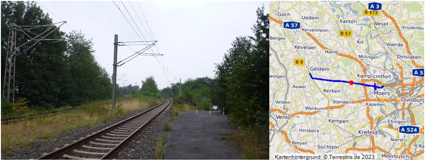
Bahnhof Baerl in Duisburg (2021) Fotograf/Urheber: Wilhelm Damschen
