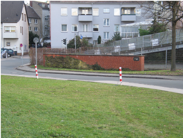
Abschnitt der Stadtmauer in Essen-Steele (2011) Fotograf/Urheber: Claus Weber
