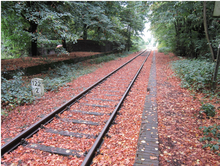
Bahnsteigkante (rechts) des ehemaligen Haltepunktes Donsbrüggen, von Osten gesehen (2013) Fotograf/Urheber: Weber, Claus
