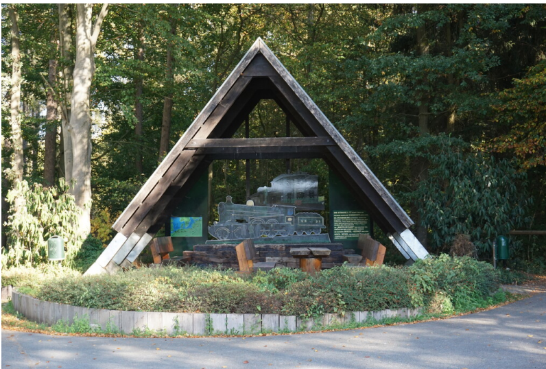
Denkmal für die Boxteler Bahn in Kalbeck (2018) Fotograf/Urheber: Claus Weber
