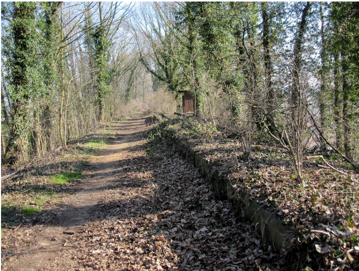
Bahndamm der Boxteler Bahn in Uedemerbruch (2011) Fotograf/Urheber: Burggraaff, Peter
