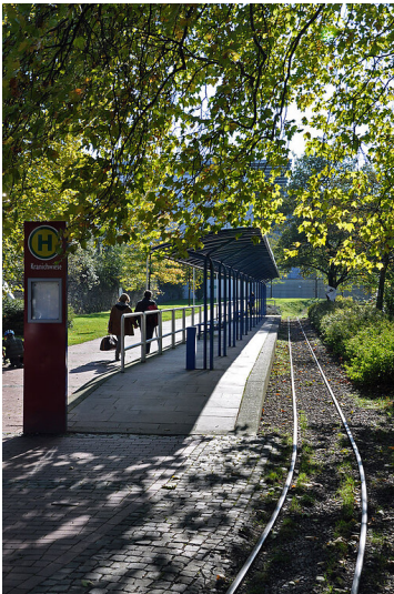
Haltestelle der Essener Grugabahn am Messegelände (2011). Fotograf/Urheber: Goofy50
