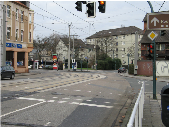
Straßenbahn-Wendeschleife Hanielstraße in Essen-Katernberg (2011) Fotograf/Urheber: Claus Weber
